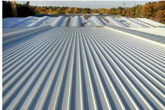
Das Dach des Gießener Firmengebäudes wurde mit Sandwichelementen eingedeckt
