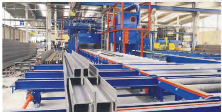
Neues Langgut-Hochregallager und neue Strahlanlage bei Bieber + Marburg in Gießen.
